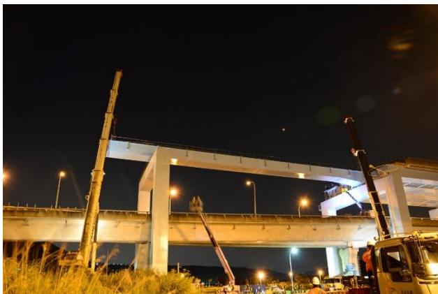
圖 1：淡江大橋第 1 標工程鋼墩帽梁及鋼箱梁吊裝
