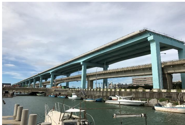
圖 2：淡江大橋第 1 標工程竣工現況圖
