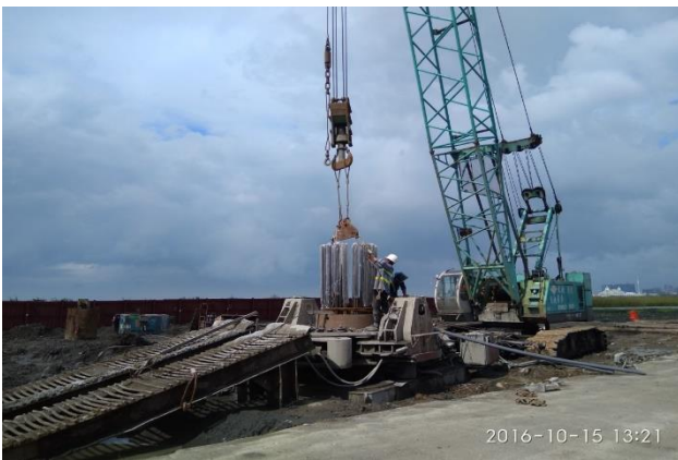
圖 3：淡江大橋第 2 標基樁工程施工
